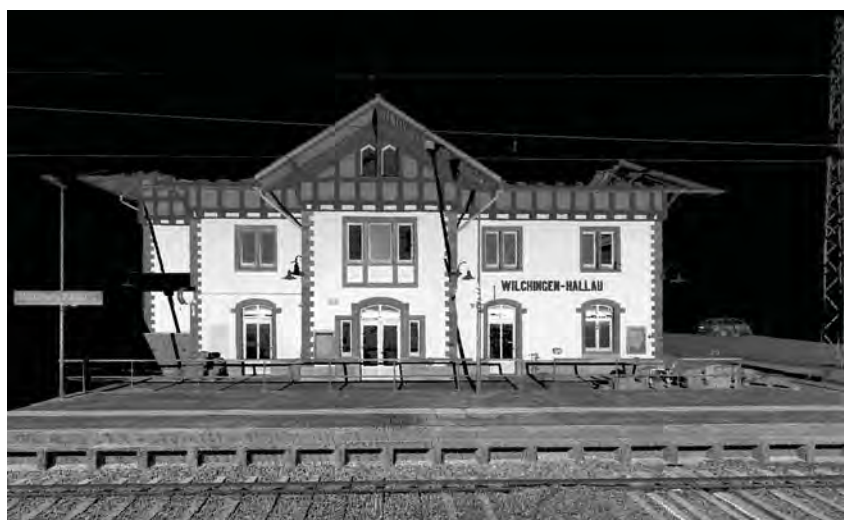
Punktwolke eines Bahnhofsgebäudes in der Schweiz, aufgenommen mit dem Z+F PROFILER® 9012 (Bild: IGI).
